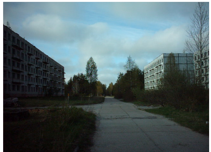
Ehemaliger Wissenschaftlerkomplex neben dem Radioteleskop mittlerweile eine Geisterstadt
