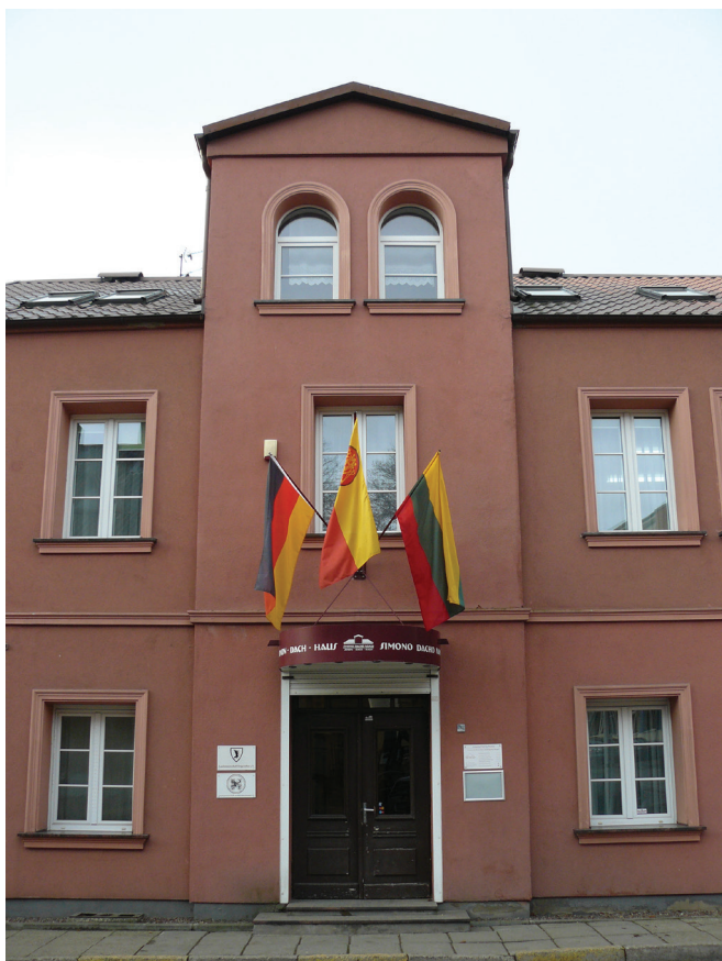
Simon Dach Haus in Klaipeda
