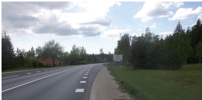
Neue Strasse Riga-Ventspils
