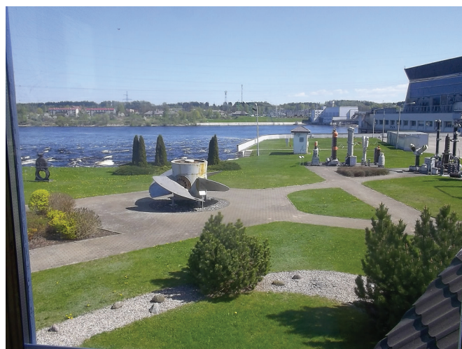
Kegumu HES mit einer Gesamtleistung von 192 MW und einer Stauhöhe von 14 Metern
