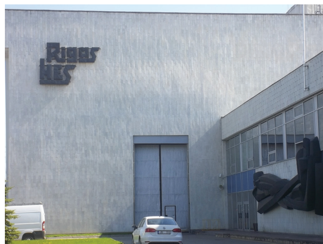
Rigas HES mit einer Gesamtleistung von 402 MW und einer Stauhöhe von 34 Metern
