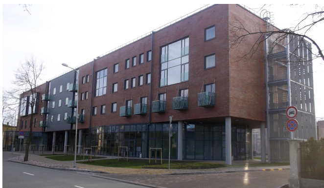
Das neue Ventspils Technikum
